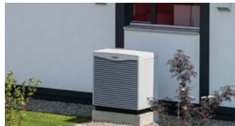
Die Luft-Luft-Wärmepumpe entzieht der Außenluft Wärme, um damit die Raumluft zu erwärmen. Foto: Daniel Maurer/dpa-mag
