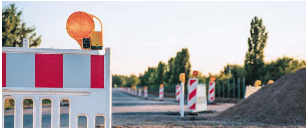
Die Vorarbeiten für die Sanierung haben bereits begonnen. Foto: Adobe Stock
