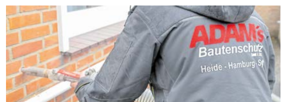
Die Luftschicht wird durch die Bohrlöcher befüllt.
