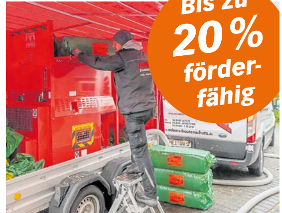
Hier wird die Steinwolle in die Einblasmaschine über dicke Schläuche direkt in die Luftschicht eingefüllt.
