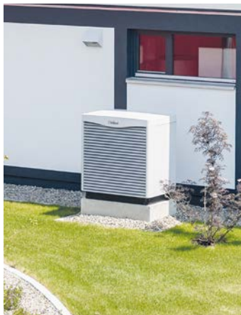
Die Luft-Luft-Wärmepumpe entzieht der Außenluft Wärme, um damit die Raumluft zu erwärmen. Sie kann aber auch Räume kühlen. Foto: Christin Klose/dpa-mag
