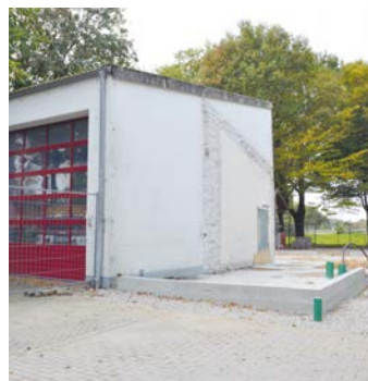
Die Sohle ist betoniert. Das neue Gebäude zieht sich um das Gebäude herum und bietet später deutlich mehr Platz für die Mitglieder der Freiwilligen Feuerwehr Sülldorf-Iserbrook. Foto: ros
