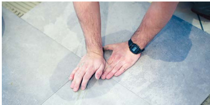
Eben und glatt soll es werden: Dafür untersucht man vorher den Boden mit Hilfe der Klopf-Probe zuerst auf hohle Stellen.
