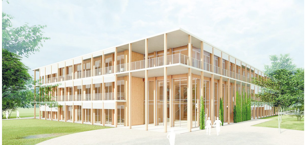
Das dreigeschossige Oberstufenhaus aus Holz enthält ein Gründach, und die Gebäudetechnik umfasst eine Wärmepumpe sowie eine Photovoltaikanlage.
