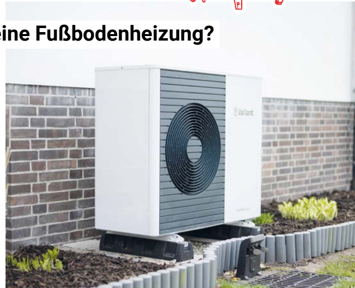
Wärmepumpen arbeiten umso effizienter, je besser der Wärmeschutz eines Gebäudes ausfällt, etwa durch Dämmung und moderne Fenster.
